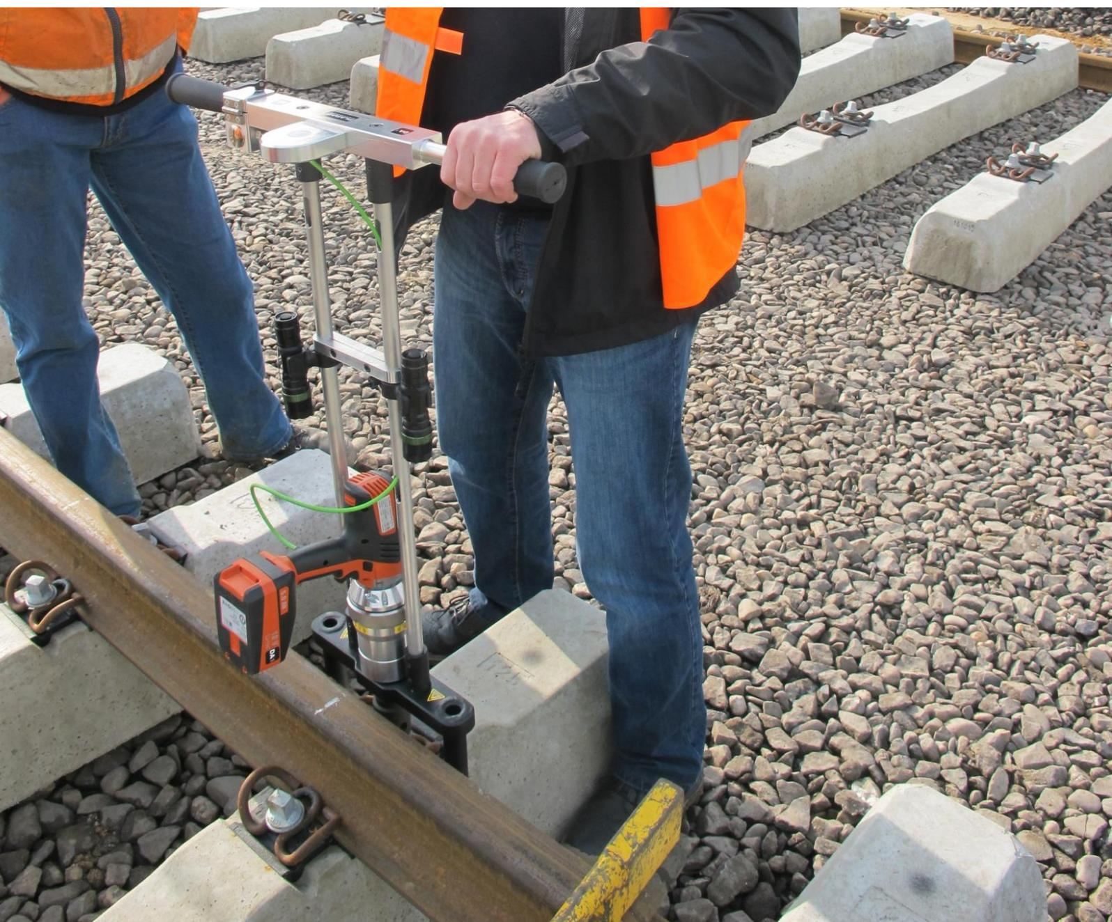
Lo stato dell'arte della tecnologia **PLARAD** nel settore degli avvitatori a coppia controllata ha dato vita alla nuova unità di avvitamento **RailTorque** specificatamente progettata per le applicazioni di serraggio delle traversine ferroviarie
